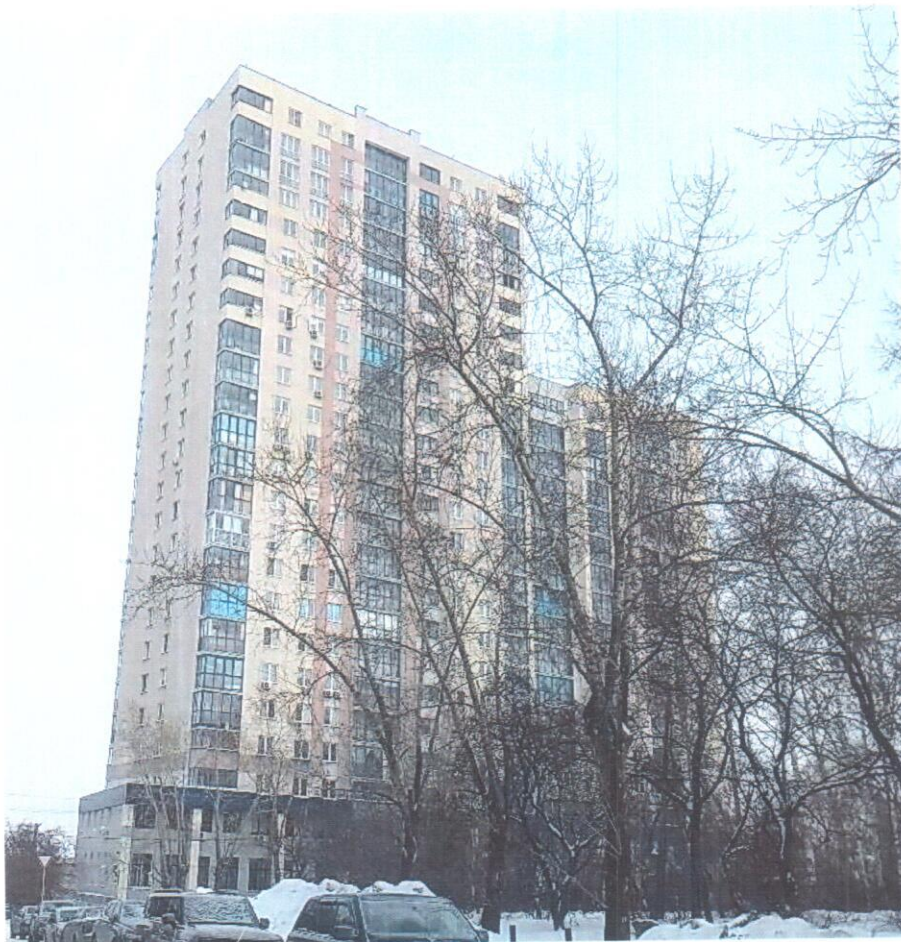
Фотоиллюстрация 1. Многоквартирный жилой дом по адресу: г. Екатеринбург, ул. Аптекарская, 48
